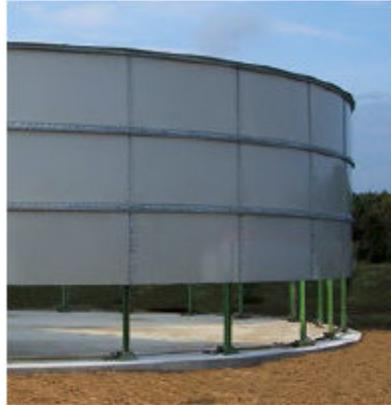
hoeba -Behälter, mit einem Volumen von bis zu 20.000 m<sup>3</sup>, werden ohne aufwendige Gerüstkonstruktionen oder Kranarbeiten montiert. Zuerst wird ein geschlossenes Ringsegment erstellt. Die fertigen Ringsegmente werden mittels eines Hubspindel systems auf dem Fundament angehoben und der nächste Segmentring darunter gesetzt. Durch diese Technik wird der Behälter von oben nach unten montiert. Somit sind extrem kurze Montagezeiten möglich.
