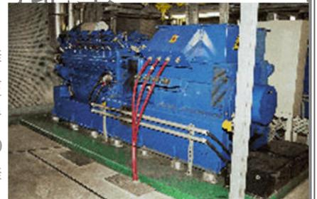
自1957年以来，发酵气体（沼气）变成了带有沼气的污水处理厂的电能来源。丢弃的余热被用于供暖。1998年，污水处理厂中的气体能量装置被一个现代化的热电厂（热电联产）代替。其中包含沼气发电和热能的产生。
