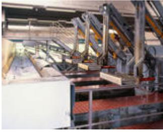
首先，污水再计算机控制下经过机械处理阶段。较大的污物，如树叶，木材，纸张或包装材料在水中由格栅滤出，然后洗净这些废物，压制，然后焚烧或填埋。
